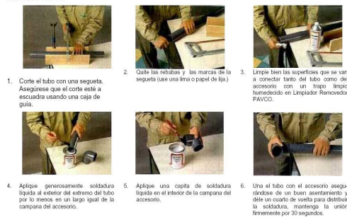
Imagen 7.11. Instalación tuberías.
