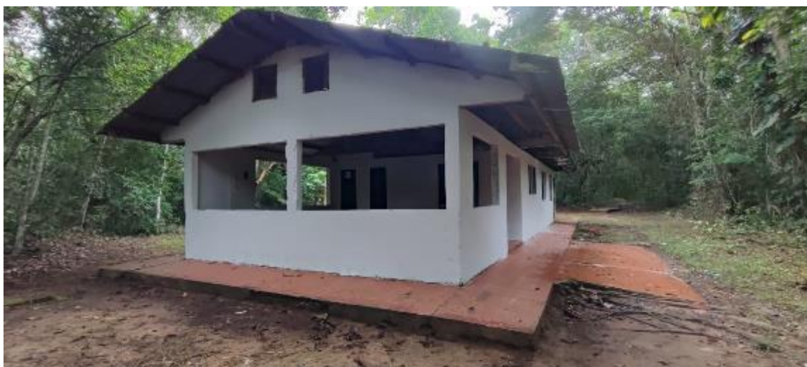
Imagen 2. Estado actual Centro de interpretación ambiental.
