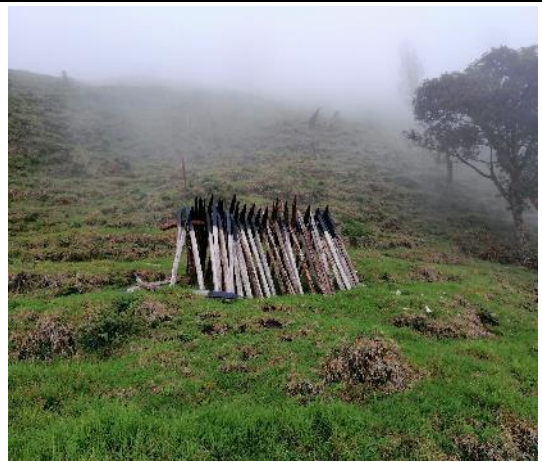
Imagen 19. Impermeabilización de postes para la construcción de sistema silvopastoril, predio san Antonio.
