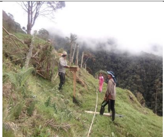
Imagen 15. Trazado y construcción de sistema silvopastoril, predio Miravalle.
