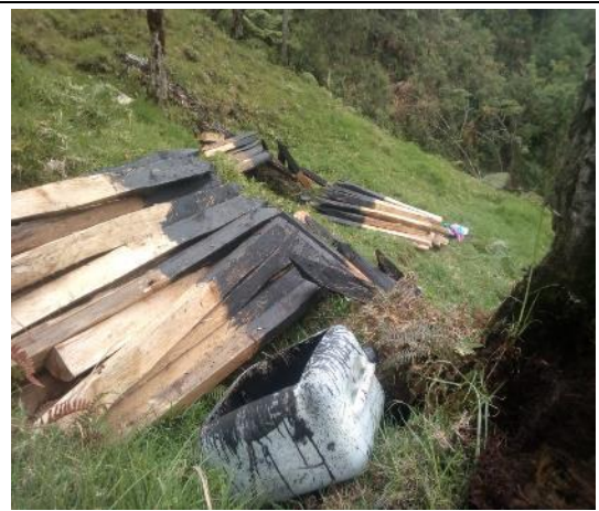
Imagen 21. Impermeabilización de postes para la construcción de sistema silvopastoril, predio san Antonio, predio el cañon.
