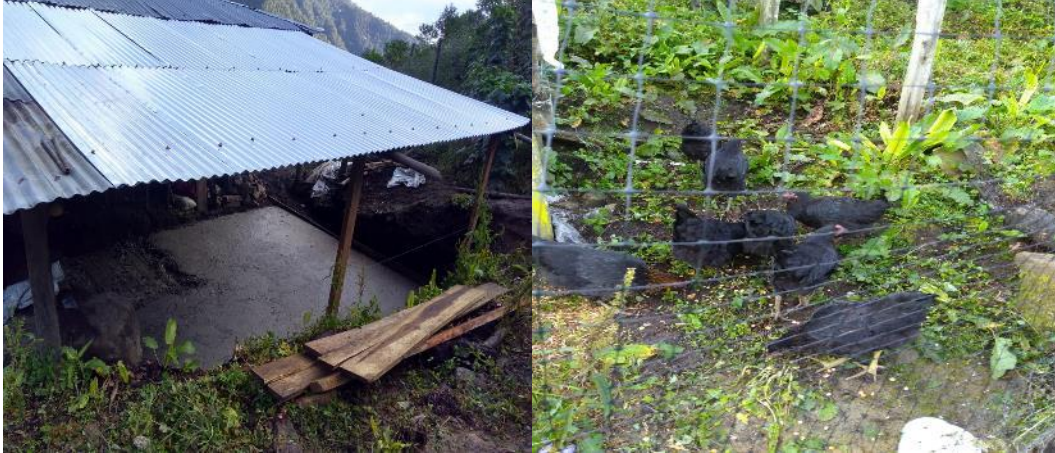
Imagen 8. Preparación de terreno para el establecimiento de biofabrica
