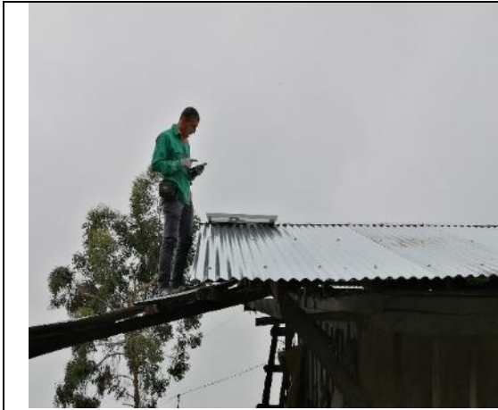
Imagen 16. Instalación de sistema fotovoltaico para el funcionamiento del sistema silvopastoril, predio miravalle
