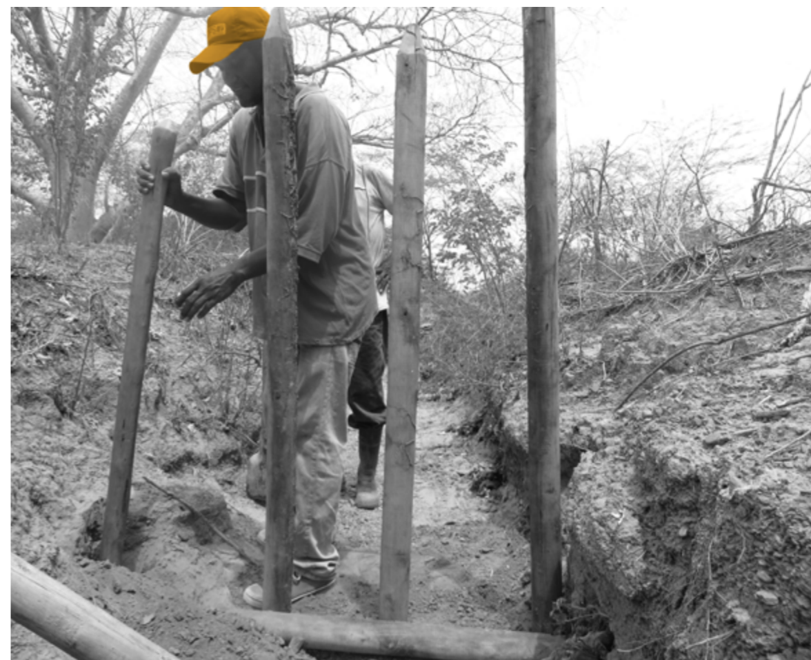
Figura 8. Construcción de obra, Hibácharo, Piojó, departamento del Atlántico. Fuente: Jesús Castillo, Álvaro Ceballos Freire y Jorge Baguí
