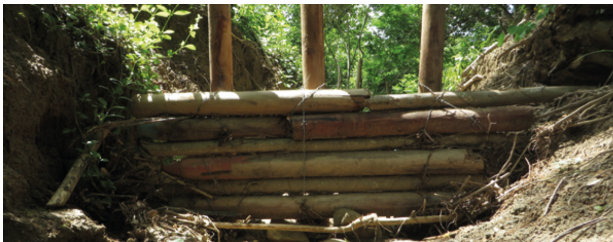
Figuras 34 y 35. Estructuras para contención de suelo. Hibácharo, Atlántico Fotos: Javier Ceballos y Jesús Castillo
